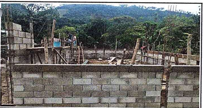
Foto 5: REHABILITACIÓN DEL MÓDULO 3
