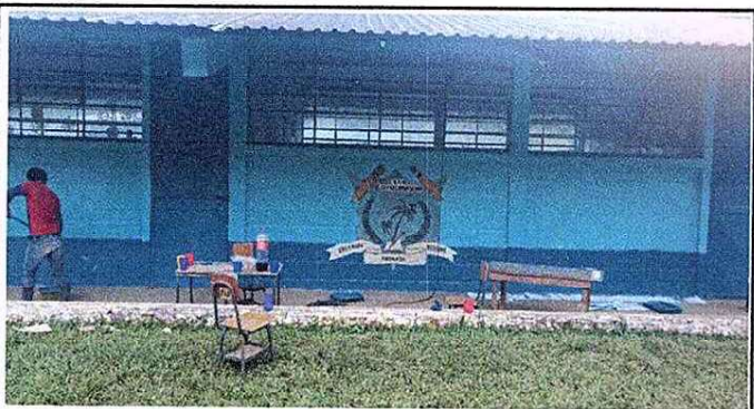
Foto 3: APLICACIÓN DE PINTURA EN LOS EXTERIORES E INTERIORES DEL MÓDULO 1
