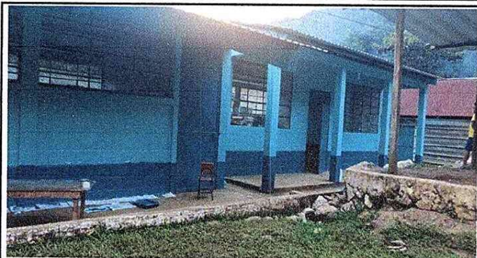
Foto 1: SUSTITUCIÓN DE PUERTAS DE METALES DEL MÓDULO 3
