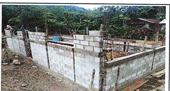
Foto 6: REHABILITACIÓN DEL MÓDULO 3
